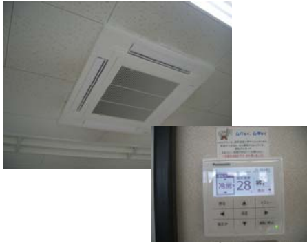
写真①(設備交換)
