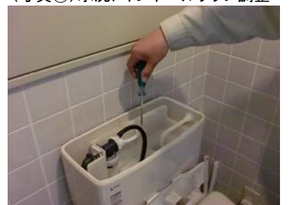
(写真⑩)水洗トイレボールタップ調整
