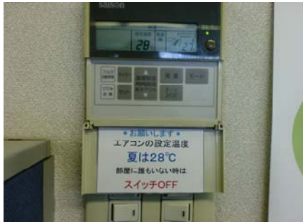
写真④(冷暖房の温度設定管理)
